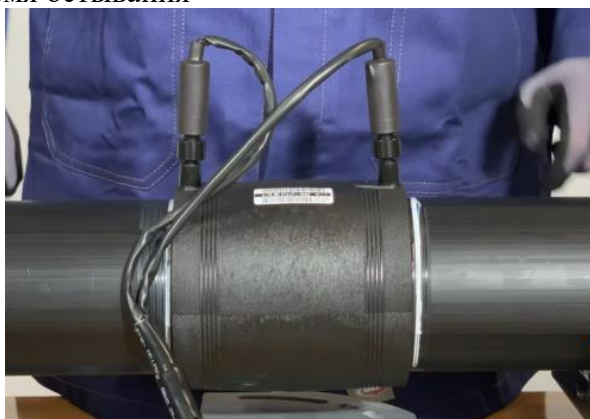
Рисунок Б.6 – Сваривание мuffты
