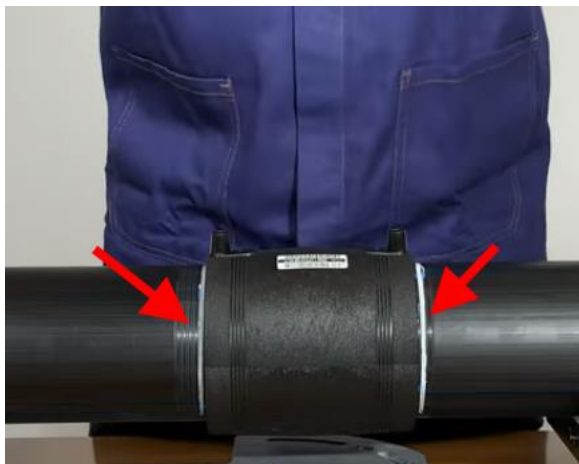
Рисунок Б.5 – Установка мuffты
