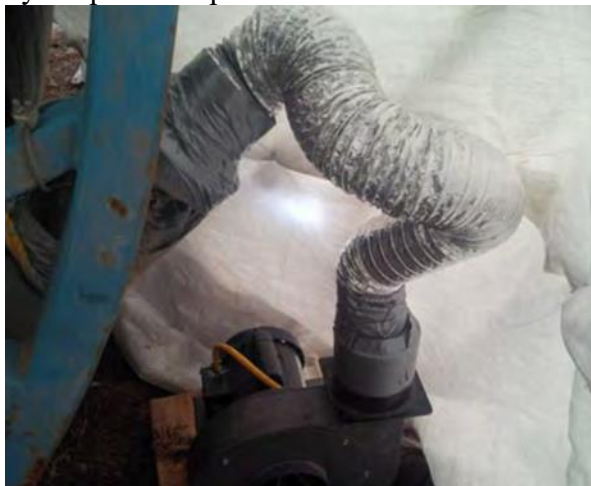
Рисунок 33 – Схема внутреннего нагрева трубы
