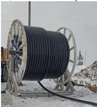
Рисунок 16 – А-образная опорная конструкция
