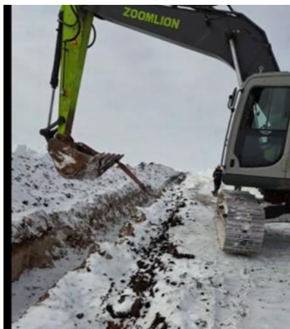
Рисунок 21 – Протяжка трубы строительной техникой
