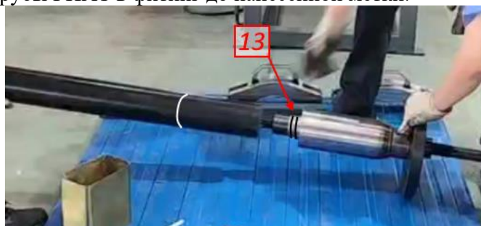
Рисунок А.2 – Установка трубы в фитинг
